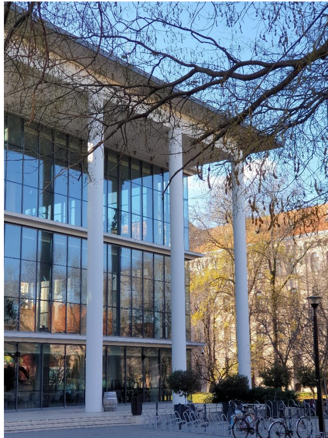
A Tanulmányi és Információs Központ épülete (9. számú kép)
